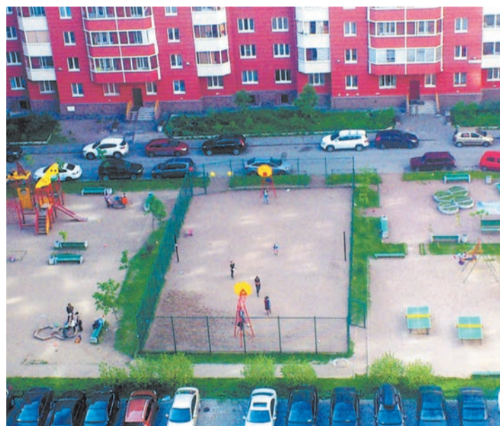
ул. Долгоозерная, д. 31, корп. 1. Вид двора ДО ремонта
